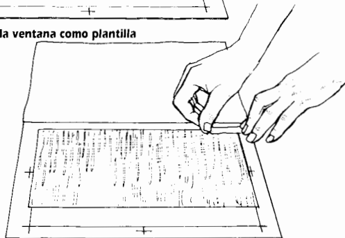
4 Corte la chapa de madera y fíjela en su posición definitiva
